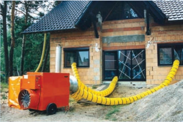
Temporäre Beheizung von Neubauten
