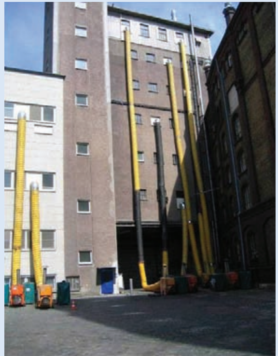
Entwesung von Gebäuden
